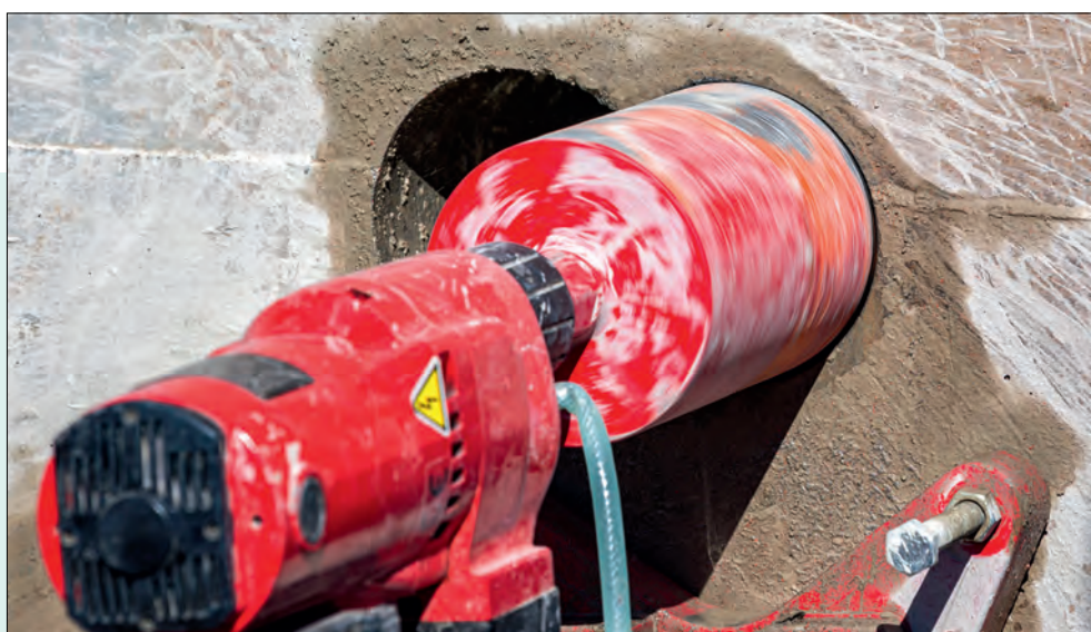
Abb. 1: Angreifer versuchen immer wieder, Wände, Decken oder andere Trennflächen zu durchbrechen – diese Strukturen stellen oft kritische Schwachstellen von Gebäuden dar (Foto: Funtay/ stock.adobe.com)
